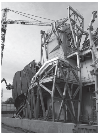
Figura 11. Se aprecia la estructura a la vez que las formas alabeadas de fachada de la Fondation Louis Vuitton. Fuente: Anna Maria Bordas
