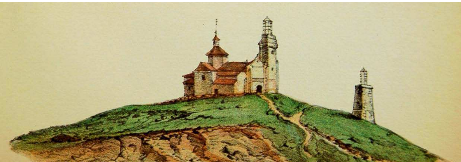
Imagen del Cerro de los Ángeles a las afueras de Getafe, por donde pasaban en paralelo junto a la Nacional IV la línea de Andalucía y la del Palacio de Aranjuez. Una de ellas utilizó el campanario de la ermita y la otra una torre típica del telégrafo edificada ex profeso . La utilización de cerros y puntos elevados fue la norma en los trazados (Mieg 1984).
