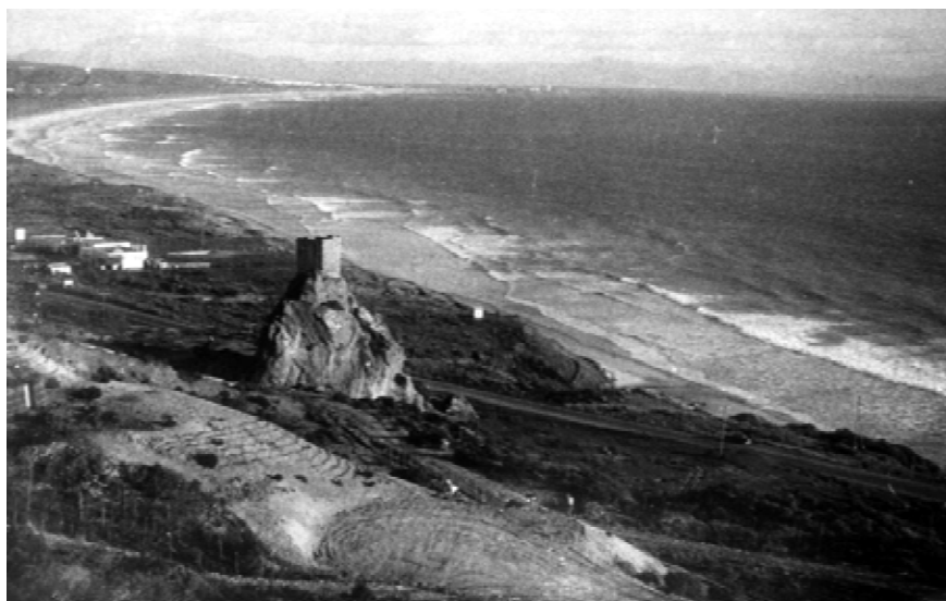
Ilustración 10.- Vista del paso de la torre de la Peña. Colección particular.
