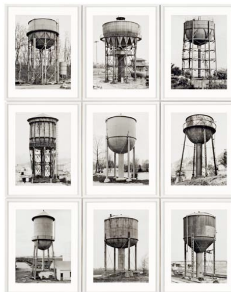
Fig. 13, Torres de agua , 1967-1980, Bern y Hilla Becher. Fuente: The Metropolitan Museum
