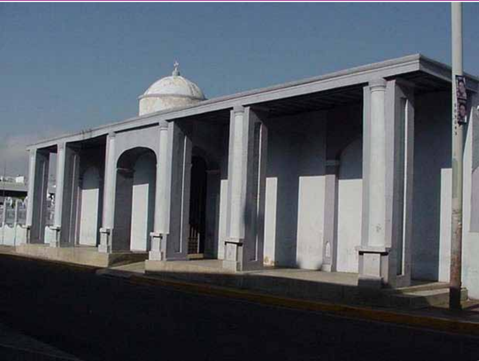
Fachada principal del Cementerio El Cuadrado
