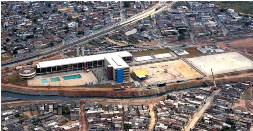
Foto 1 – Vista Aérea do CEU Jembeiro 1
