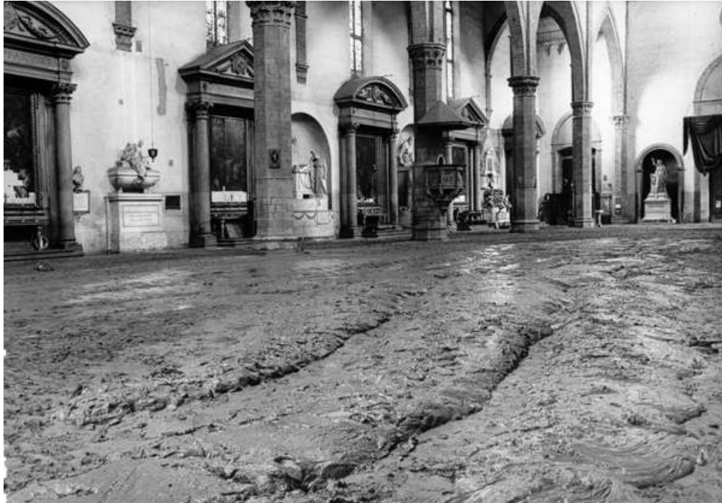
Interior de la Iglesia de Santa Croce, con el aluvión de 1966, completamente enlodada.
