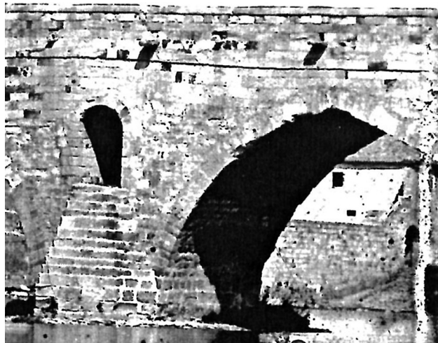
Figura 31: Puente sobre el Duero en Zamora (J. Laurent). Detalle del arco 8 desde aguas abajo.
