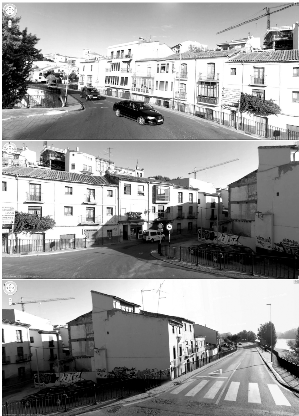
Figuras 33, 34 y 35: Rampas de acceso al puente desde su extremo norte. Estado actual.
