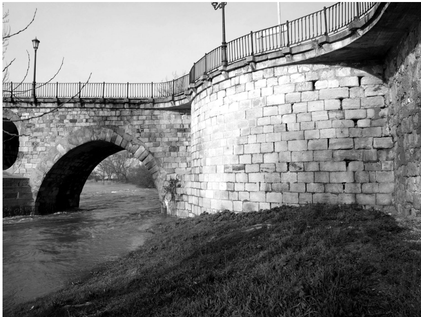
Figura 22: Arco 15 y embocadura del puente, vistos desde el paseo fluvial, en la actualidad.
