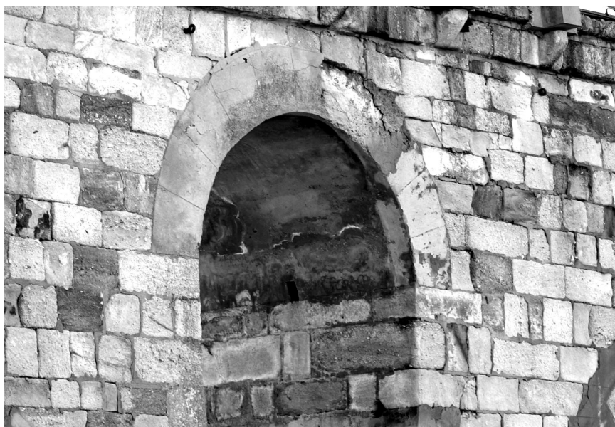
Figura 16: Vista desde aguas abajo del aliviadero de la pila 14, con detalle de mechina.
