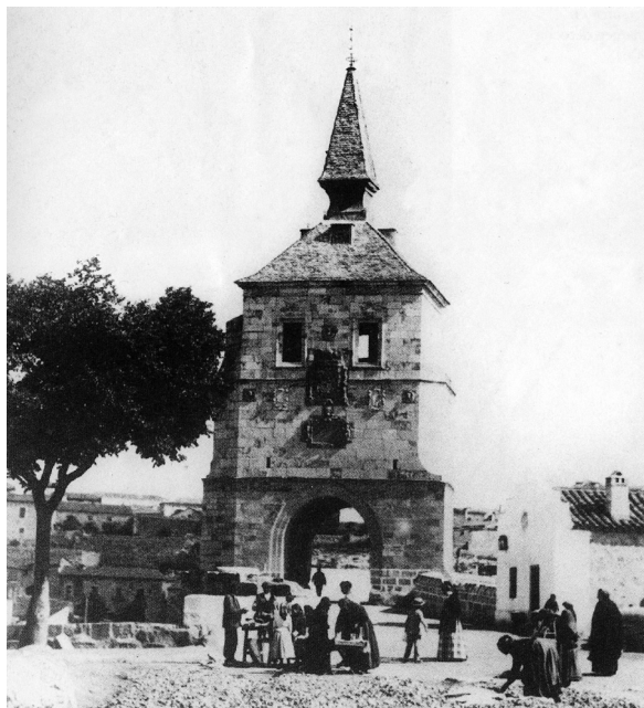
Figura 5: Vista de la torre de La Gobernación desde el sur.
