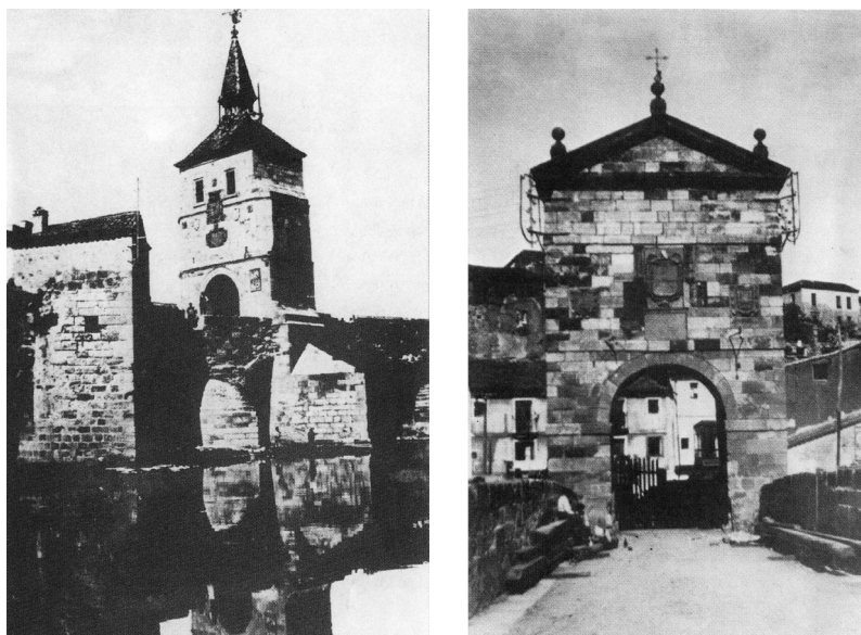
Figuras 7 y 8: Vista de las torres del puente de piedra desde el sur.
