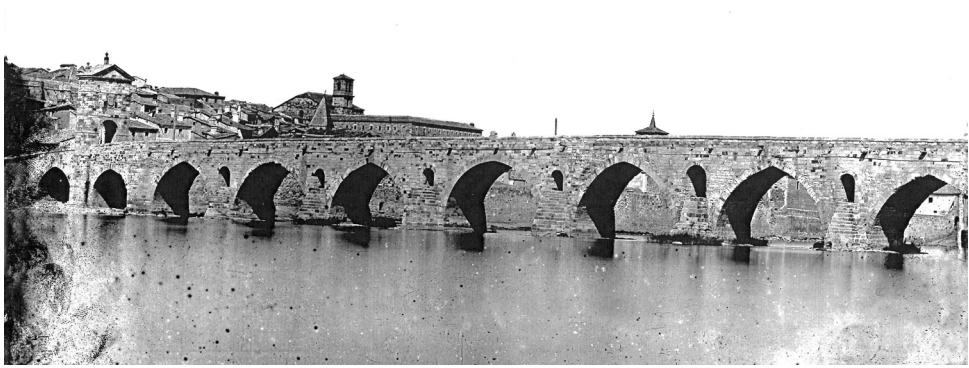
Figura 1: Puente sobre el Duero en Zamora (J. Laurent) Fotografía de la mitad septentrional (arcos 16 a 8).
