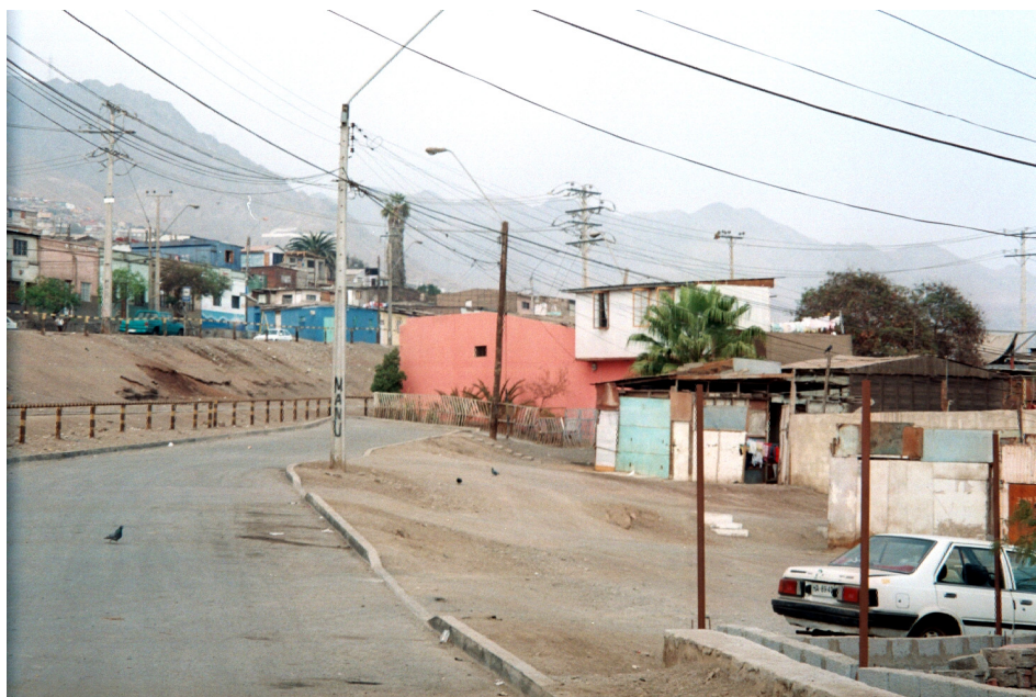
Figura 15. Calle Atacama, adyacente a la vía ferroviaria.
