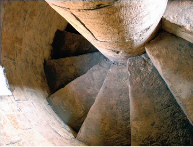
Fig. 10. Il Cairo. Vis de Saint Gilles nella porta di Bab-al-Nasr (foto di F. Mannuccia).
