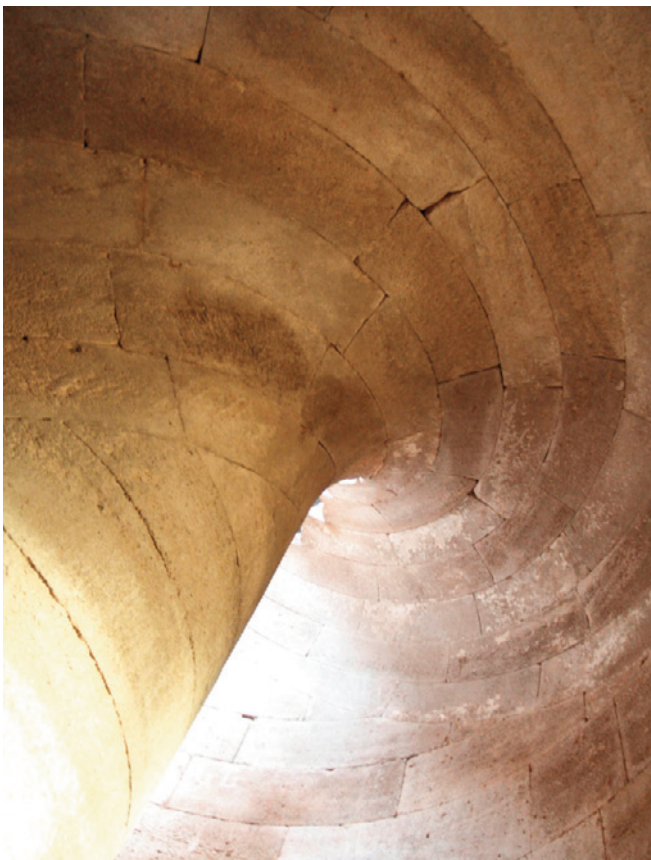
Fig. 2. Abbazia di Saint Gilles du Gard, scala a chiocciola con volta elicoidale della torre campanaria (foto dell'autore).
