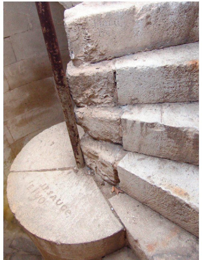
Fig. 3. Abbazia di Saint Gilles du Gard, ultimi gradini della scala incastrati al nucleo centrale (foto dell'autore).
