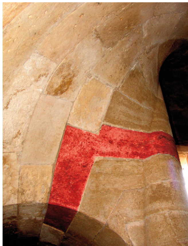
Figg. 4-5-6. Siracusa. Castello Maniace, vis de Saint Gilles , particolare del "conco tipo"; conci complessi di attacco tra la volta cilindrica e quella elicoidale; in rosso il concio di chiave (foto dell'autore).
