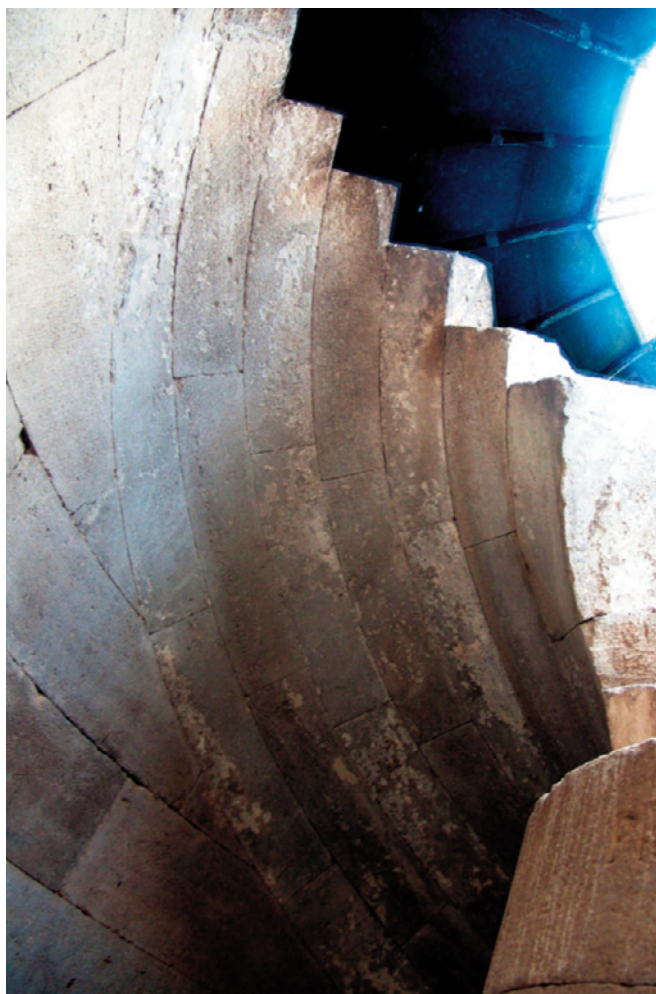
Fig. 8. Abbazia di Saint Gilles du Gard, parte terminale della volta elicoidale (foto dell'autore).
