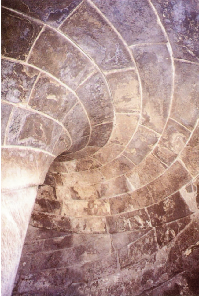
Fig. 1. El Cairo. Puerta de las Victorias, escalera con bóveda de cañón helicoidal (da Una Arquitectura gotica..., cit.).
