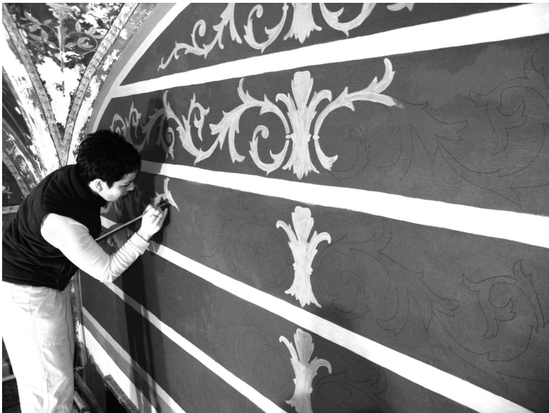
Fig. 11 Aplicació de pintura damunt el nou suport
