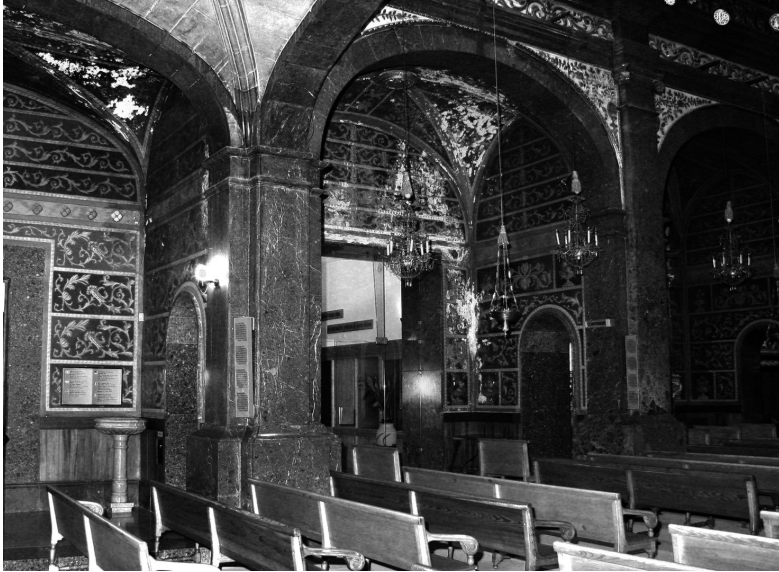
Fig. 1 Aspecte general abans de la intervenció
