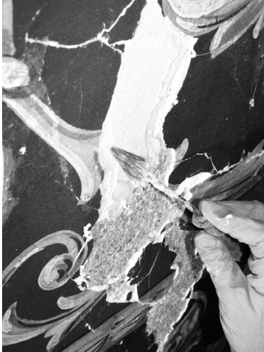
Fig. 6 Aplicació del morter a les llacunes
