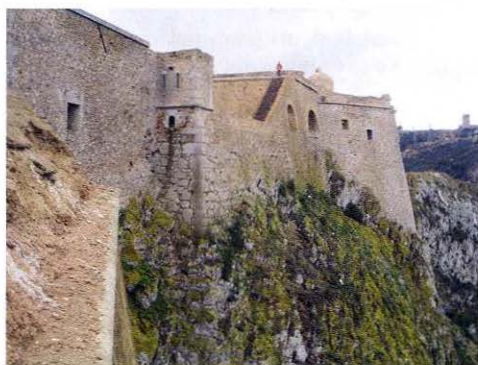
13. Le flanc Nord du fort Santa Cruz.
