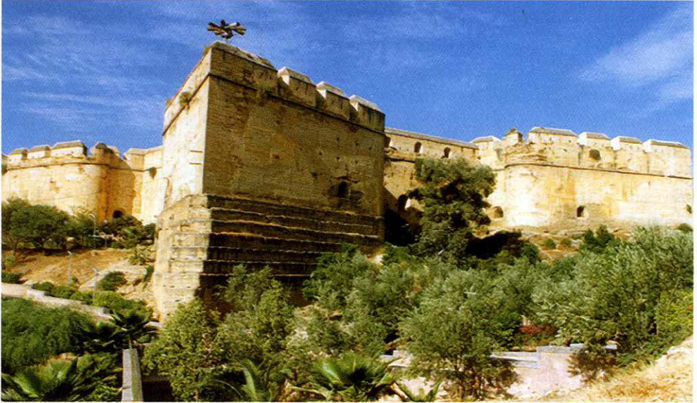
Fig. 2. Vista del bordj antes de su restauración.
