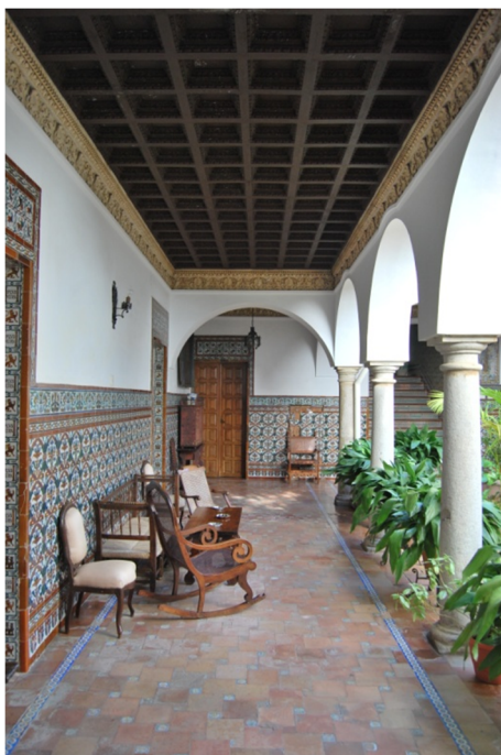
Fot. 5. Detalle de una de las galerías de la planta baja, en donde se aprecia el zócalo de azulejería trianera (Fot. BMD).
