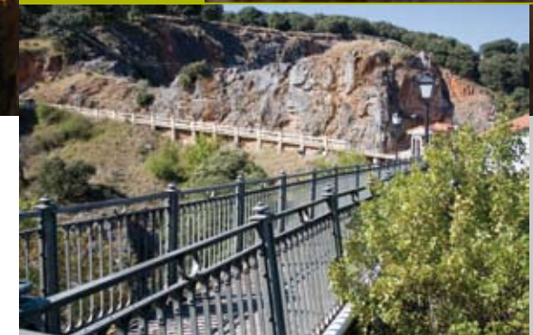
Puente de Hierro
