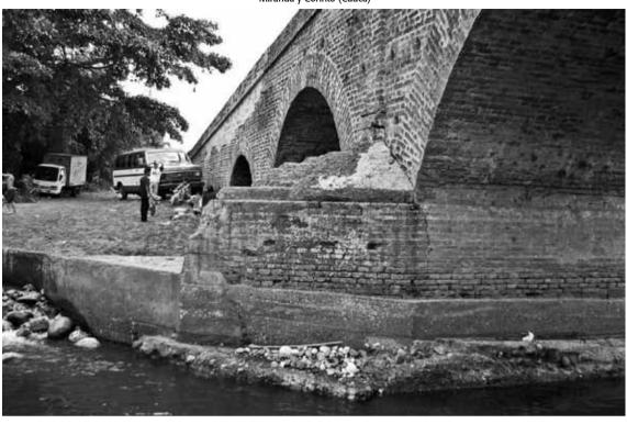
Figura 7 Puente sobre el río Ovejas. A la izquierda, tímpanos desplazados hacia afuera por efecto del empuje horizontal del material de relleno. A la derecha, desgaste de la superficie de rodamiento por el tránsito de personas y animales
