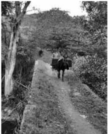
temperatura de horneado, heterogeneidad de la materia prima, cortos tiempos de cocción, entre otros. En el puente sobre el río Grande, en Caloto (construido entre 1903-06), son evidentes serios procesos de meteorización
