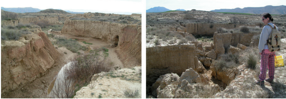
Figura 5. A) Vista general del barranco principal del área de estudio. En el margen derecho se puede observar un puente natural formado en el outlet de un gran pipe. B) Detalle de ese pipe con el puente natural colapsado. La imagen está tomada desde el margen del pipe y se observa al fondo el barranco.
