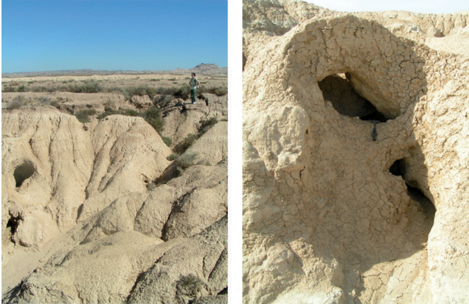
Figura 2. Dos aspectos en campo de los pipes desarrollados por procesos de seepage en las formaciones arcillosas de los rellenos de la cuenca.
