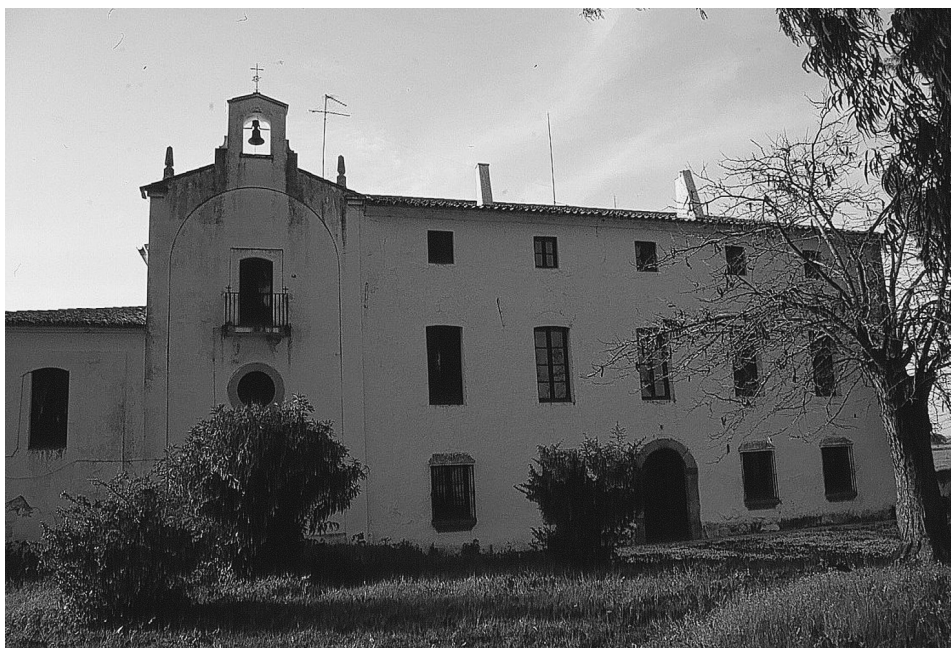
FIG. 4. Campomanes. Capilla y vivienda principal.
