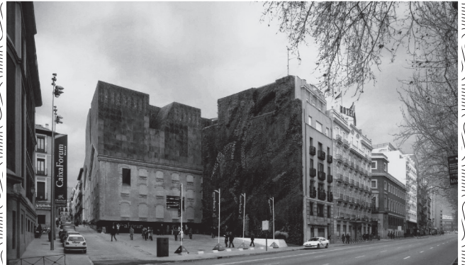
14 CAIXA FORUM, VISTA EXTERIOR.
