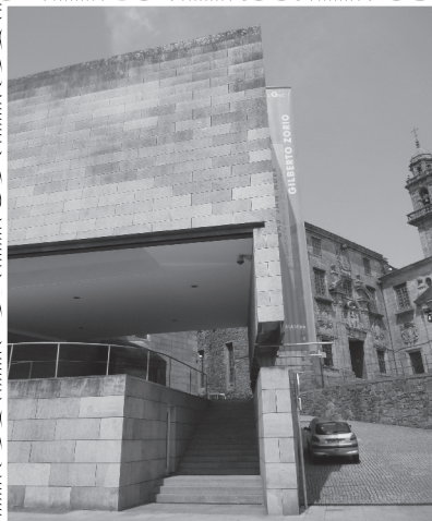
03 EL MACLAJE ENTRE LOS DOS EDIFICIOS SE REALIZA MEDIANTE RECURSOS VOLUMÉTRICOS MUY CUIDADOS, UTILIZANDO LA PERFORACIÓN O LA TRANSPARENCIA PARA VISUALIZAR PERSPECTIVAS DE APROXIMACIÓN GRADUAL.
