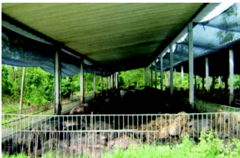
Figura 2. Instalaciones en el sistema de cama profunda utilizando racimos vacíos de palma de aceite
