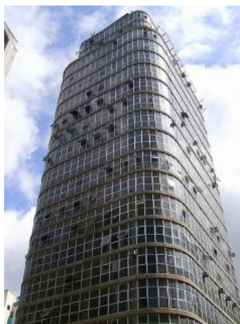
Figura 6 - Mural de Di Cavalcanti, na fachada do Edifício Triângulo.
