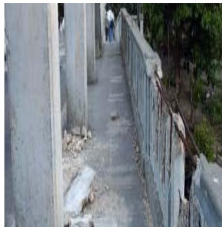
*Figura 4. Puente Sánchez Figueras (1916), obra imprescindible para la comunicación entre los barrios de Pueblo Nuevo y Matanzas, estructura vulnerable por su avanzado estado de deterioro. Imagen que recoge un desprendimiento del hormigón, fecha: 27 de marzo 2007.*
