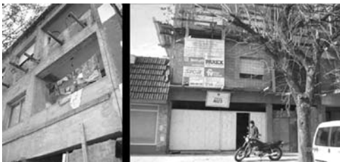
Figura 11. Estomba 1167. Edificio habitado sin terminar
