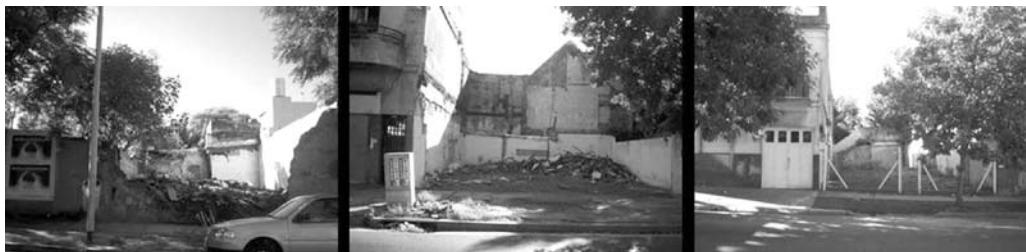
Figuras 17, 18 y 19. Viviendas en demolición, con terreno libre y con cerco de cierre de seguridad para evitar intrusiones.
