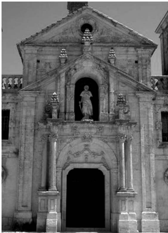
Fig. 8. Nuevo Baztán (Madrid), fachada de la iglesia de San Francisco Javier.
