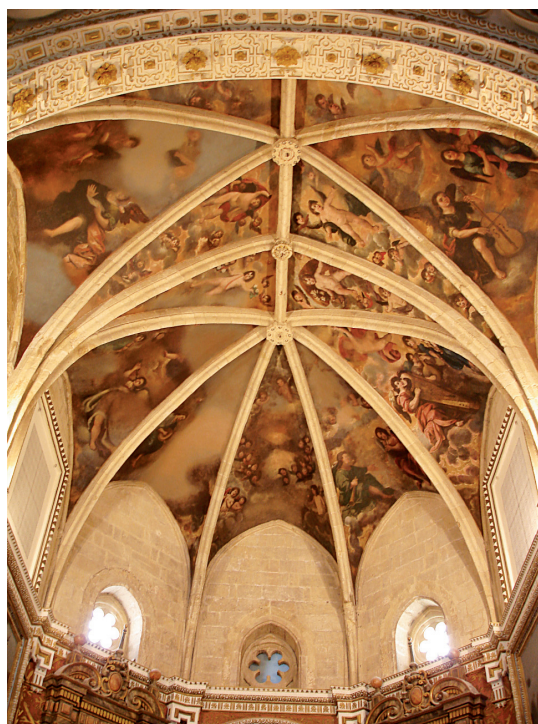
BÓVEDA DEL PRESBITERIO
