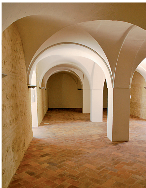
F. 8 IGLESIA PRIMITIVA TRAS LA RESTAURACIÓN.
