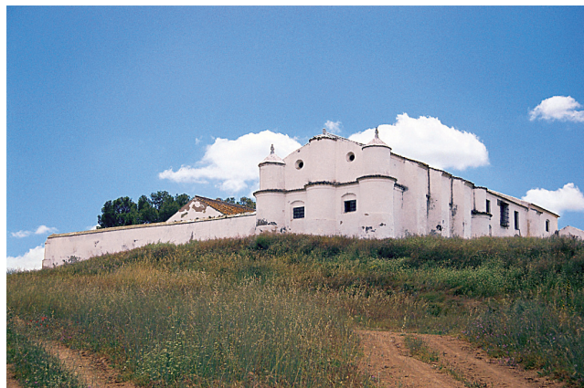
MOLINO LA CALDERONA, OSUNA (SEVILLA). FOTO: GUILLERMO PAVÓN Y FERNANDO QUILES / CONSEJERÍA DE OBRAS PÚBLICAS Y VIVIENDA.
