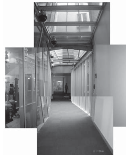
Figura 3. Imagen del hall desde el vestíbulo de ascensores con cámara de aislamiento en argón.
