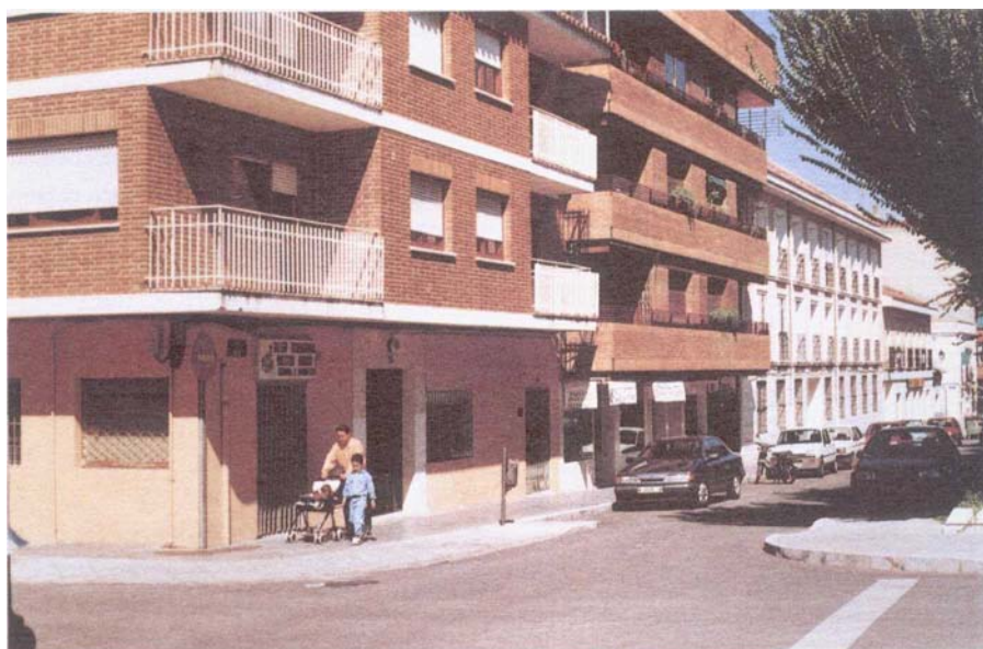
Actuaciones de renovación realizadas anteriormente a la vigencia del Plan Especial. Los edificios se alejaban de la tipología tradicional del Casco Histórico de Aranjuez. Renewal projects carried out prior to the Special Plan . Little respect was shown towards the traditional typology of the old buildings in the city centre.
