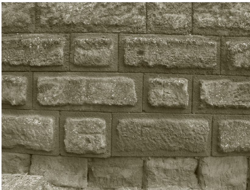
Fig. 11. Sillares y marcas de cantero en la cara norte del bastión central de la Puerta de Sevilla (Carmona). Fotografía de M. Bendala
