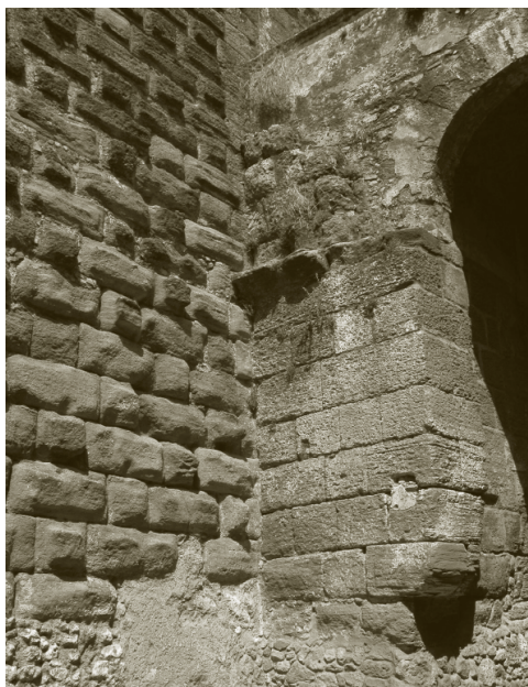
Fig. 9. Particular de la zona de adosamiento de las fábricas de las puertas romanas al muro almohadillado, en la Puerta de Sevilla (Carmona). Fotografía de M. Bendala
