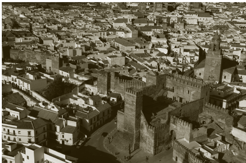
Fig. 7. Vista aérea de la fortificación de la Puerta de Sevilla, en Carmona. Cortesía de J. Blánquez
