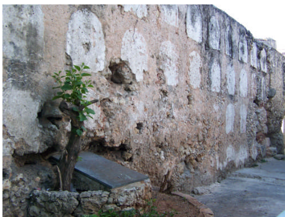
Fig. IV. Fragmento del muro de nichos perteneciente al Cementerio General. (Calles Aramburu y Vapor, Ciudad de La Habana).
