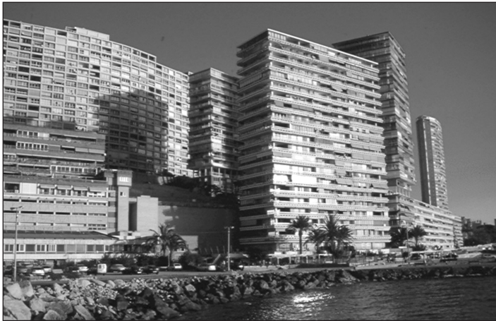
FIGURA 14. La Albufereta (Alicante). La mitad derecha de la imagen recoge los dos edificios de primera línea, de 20 y 26 alturas respectivamente, que según el último deslinde practicado, invaden la zona marítimo-terrestre, y cuya situación está pendiente de resolución por el Tribunal Supremo. Tras ellos, y al fondo a la derecha, edificios sobre suelo urbano, sobre cuya legalidad no existe controversia.
