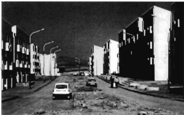
FIG. 8. BERROUAGHIA (1977): Las 400 primeras viviendas colectivas de las 3.200 asociadas al complejo de material hidráulico.
