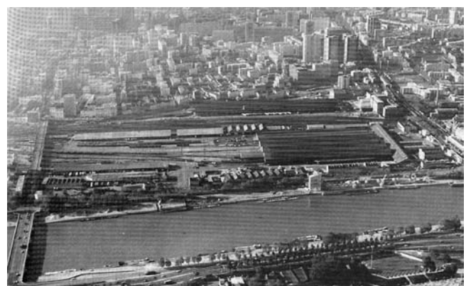
Imagen 2 Estación de mercancías de Tolbiac, la cual forma una importante ruptura entre los barrios del distrito XIII y el río Sena. Fuente: APUR (1987).
