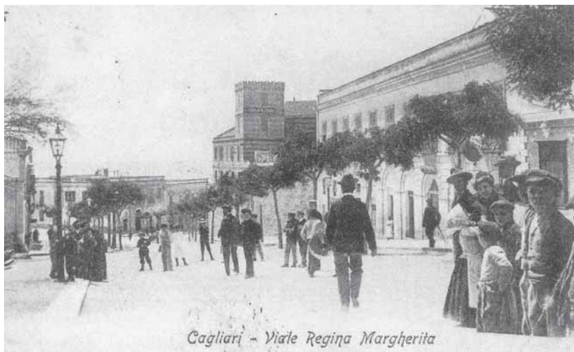
Fig. 4 – Viale Regina Margherita a Cagliari in una cartolina d’inizio Novecento, l’Albergò Scala di Ferro è al centro dell’immagine, l’insegna posta sulla torretta.
