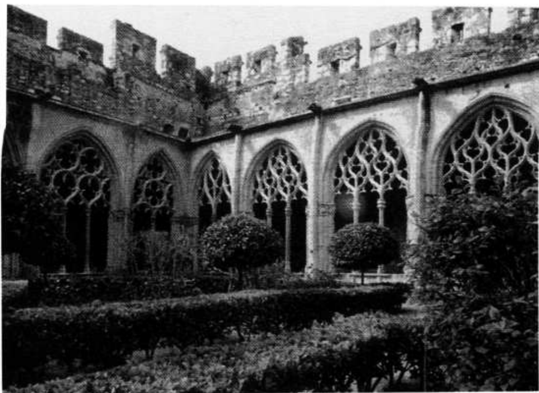
Pel damunt dels brodats dels arcs del claustre, un munt de merlets
