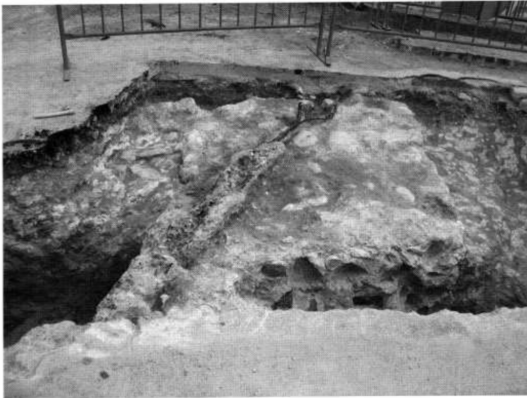
6. Fotografia des de l'est de la fonamentació localitzada.
