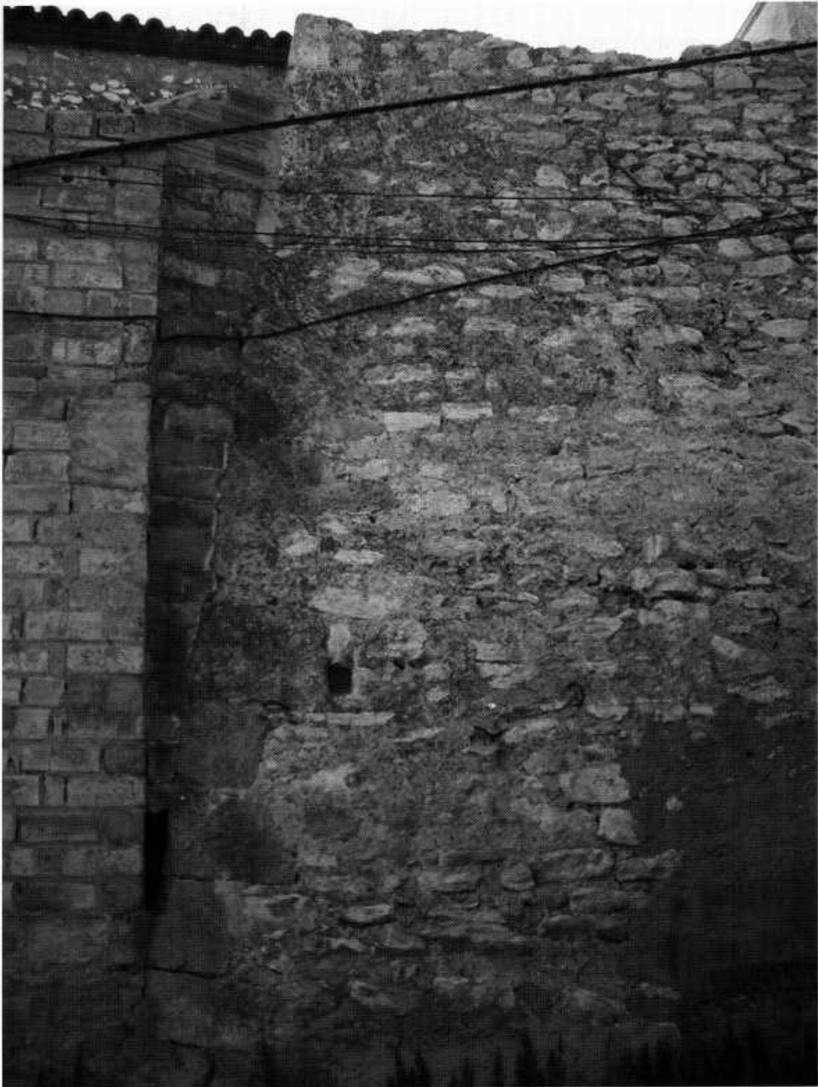
13. Detall de l'angle del baluard. Podem veure clarament la forma atalussada i el reforç de l'angle amb carreus.
