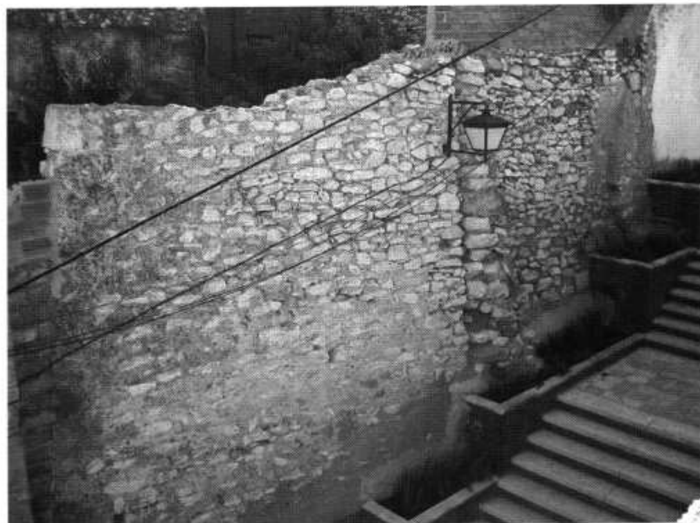
11. Fotografia general de les estructures defensives des de baix de les escales. S'observa clarament el parament del baluard.
