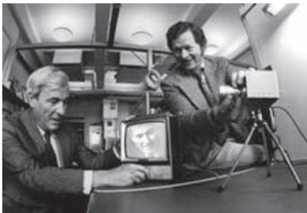
Figura 7.- W.S. Boyle (izquierda) y G.E. Smith (derecha), manipulando una cámara experimental de televisión que incorporaba un sensor CCD en lugar de un tubo de vacío (1974). (Fuente: referencia 4)
