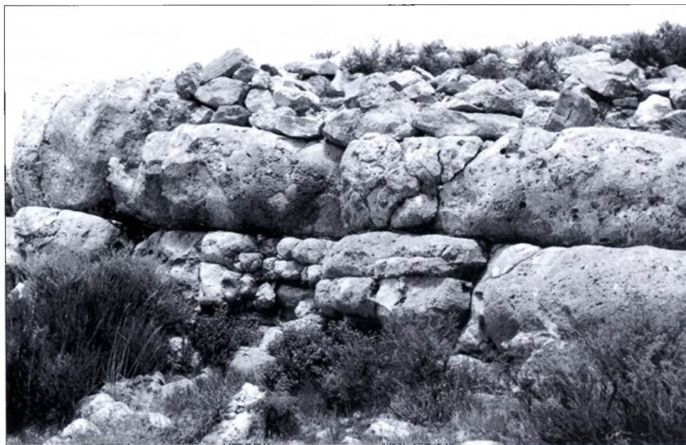
Fig. 7. Imponente tramo sur-occidental de la primera muralla con una base formada por enormes bloques rectangulares de piedras que parecen estar excavadas en la roca. (Foto: J. Alberto Cano).
