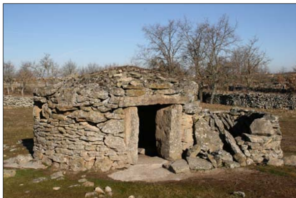
Chozo con corral adosado de Trabanca.
