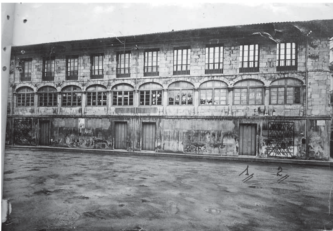
5. Fotografía que acompañaba al expediente de reformas de la fachada septentrional del palacio del marqués de Camposagrado de Avilés iniciado en 1949.
