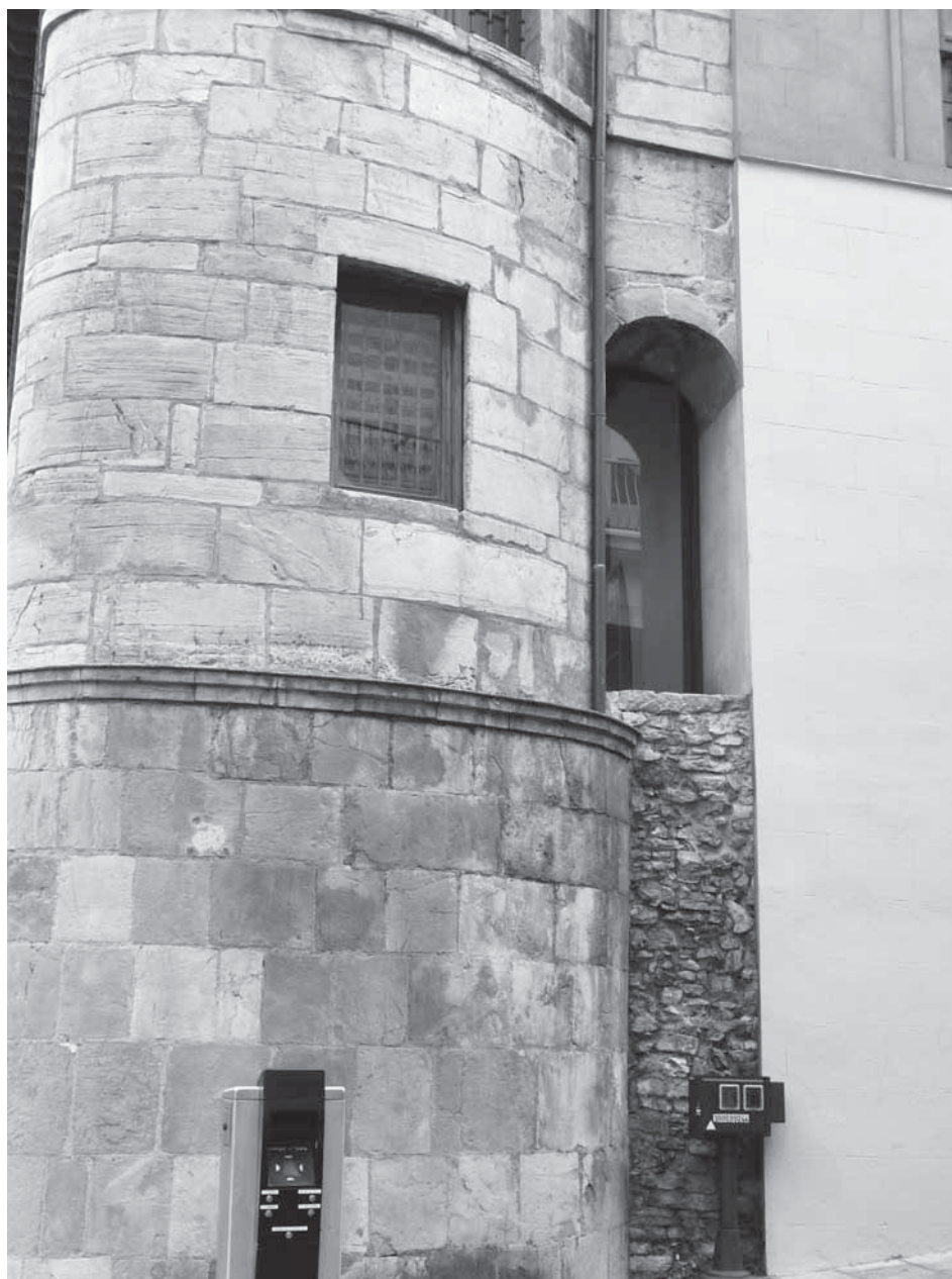
3. Tramo de muralla y arco practicado sobre la misma para garantizar la conexión con el adarve en la esquina noroccidental del palacio del marqués de Camposagrado de Avilés. El cubo se edificó sobre otro anterior perteneciente a la cerca.
