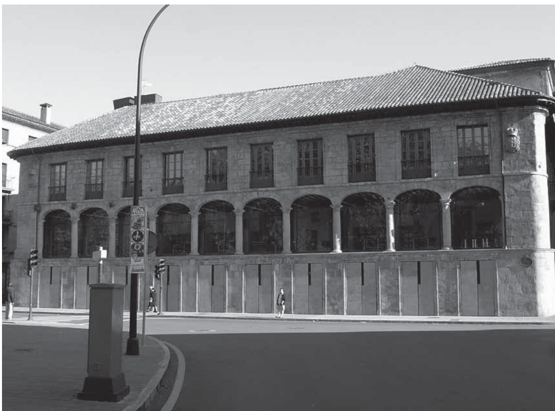
2. Fachada septentrional del palacio del marqués de Camposagrado de Avilés en la actualidad.
