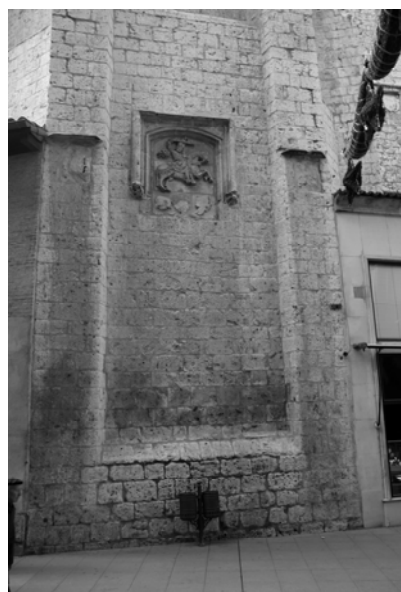
Fig. 5: Exterior de la capilla mayor de la iglesia de Santiago, Valladolid.
