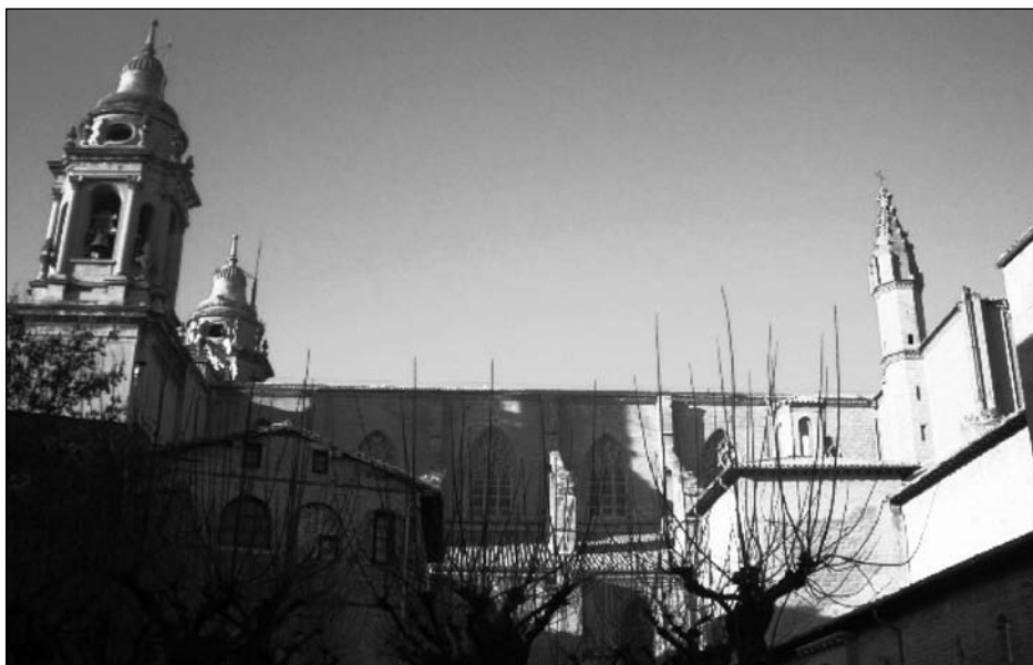
Figura 16. Vista lateral de la catedral de Pamplona
