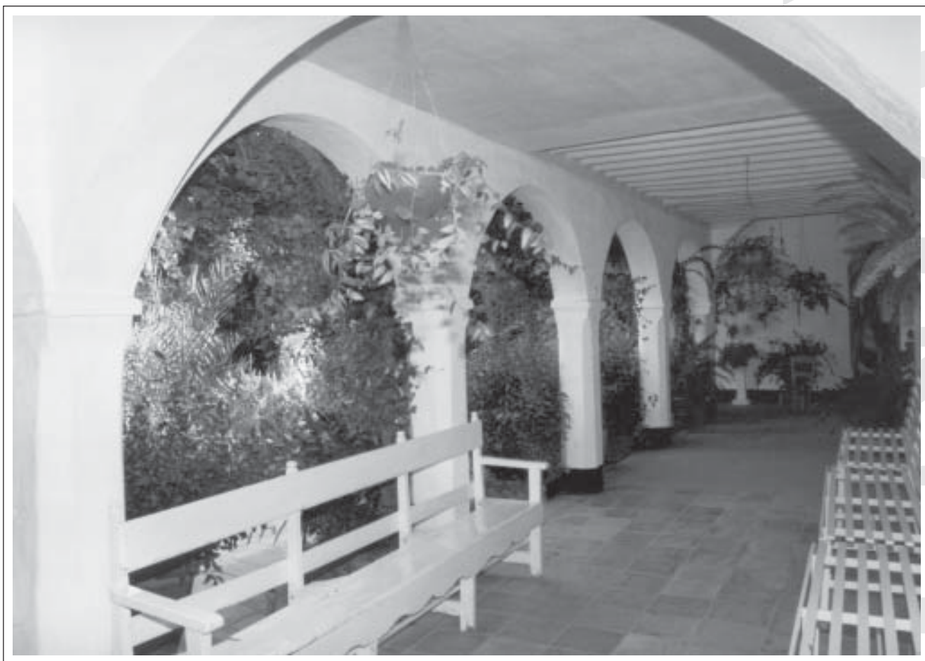
☉ Galería de arcos del patio. Planta baja del hospital. Año 1981. José L. Casado.
