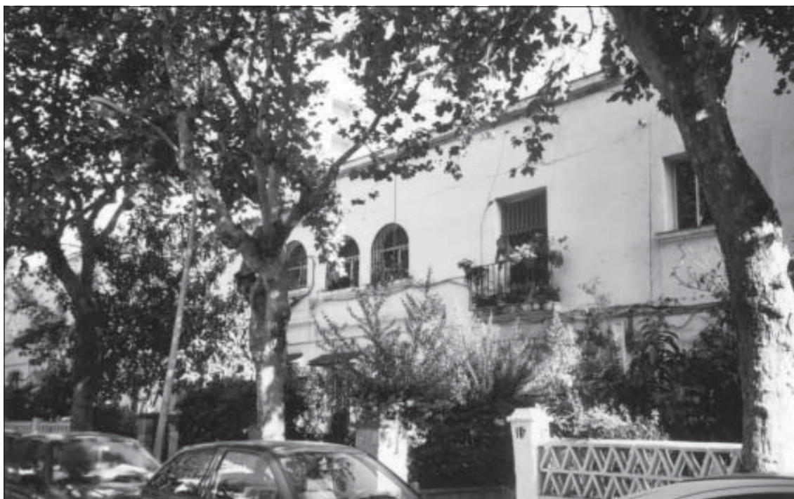
Avda. Antonio Belón. Grupo de Viviendas "Lamo de Espinosa"
