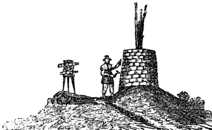
Fig. 1 - Il Mullone de sa Marmora o punto trigonometrico di 1° ordine «eretto sulla Punta Cuppetti, Monte Albo, presso Siniscola», a quota 780, venne costruito «colle sue mani incallite ... a guisa dei nostri Nuraghi e chiamato col suo nome». Al centro della struttura, come annotava il Della Marmora, «tre o quattro tronchi d'albero ... scelti ben dritti o squadri, di 3-4 metri di altezza: li collocavo nel suolo ben verticali, avendo gran cura di fissare prima un centro stabile»; questi segnali «erano sempre visibili da altri punti corrispondenti: io li distinguevo perfettamente, talora ad una distanza
