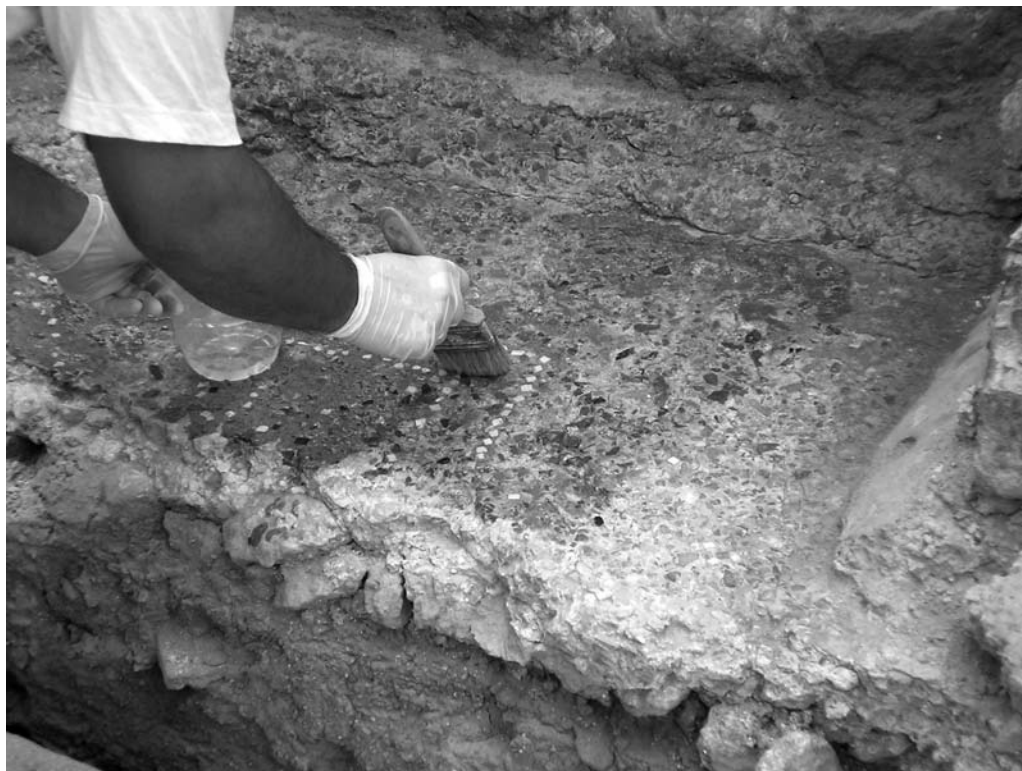
Lámina 6. Detalle de grietas en el opus signinum .
