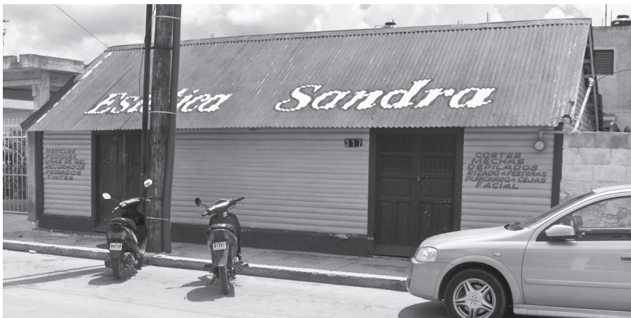
FIGURA 11. PROPIETARIA: MARÍA MARTÍN VIUDA DE AZUETA ELABORADA POR CARPINTEROS LOCALES. AÑO DE CONSTRUCCIÓN: 1951. ACTIVIDAD: ESTÉTICA.
